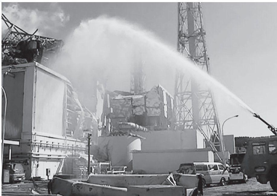
3号機建家への放水
