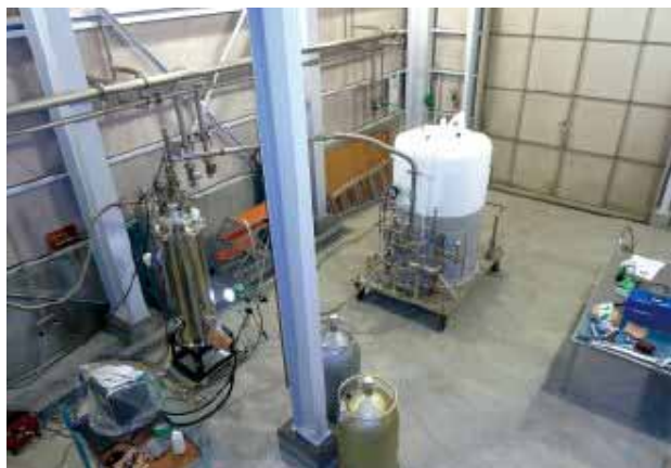
図1 水素実験棟における実験の様子
