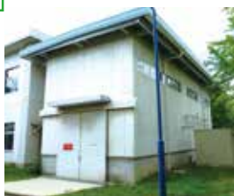
図2 水素実験棟の写真
